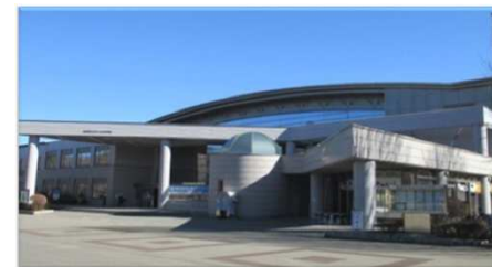
公園入口 光が丘体育館
